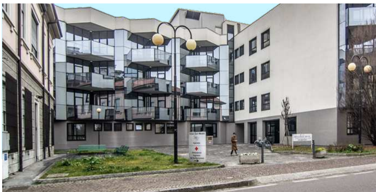
L'ingresso della RSA, in via Cantù 1 a Cesano Maderno
